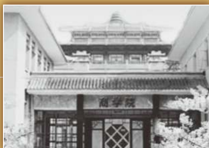
原经济学院 / 商学院大楼
